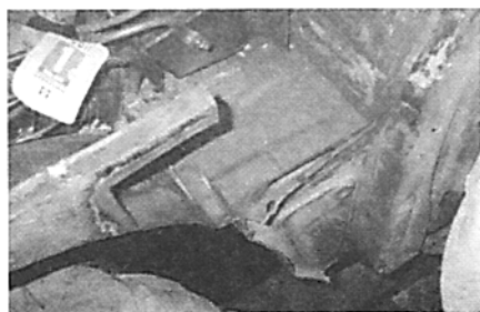
Säubern, Aufbiegen und Grundieren der Bleche vor dem Einschweißen ist erste Pflicht!
